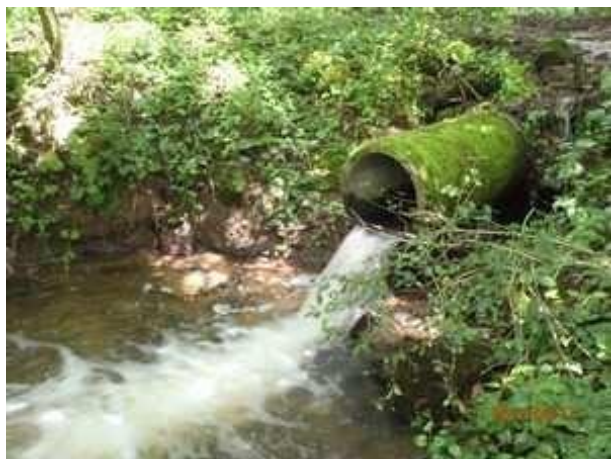
Figure 8 : Buse infranchissable sur le Moulin de Fougère
